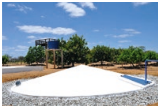
▲ Réservoir pour stocker l'eau de pluie pour la culture de vergers.
